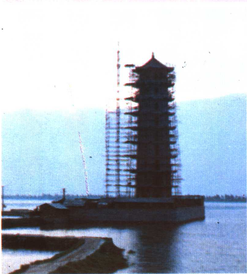
重建中的青龙山塔
