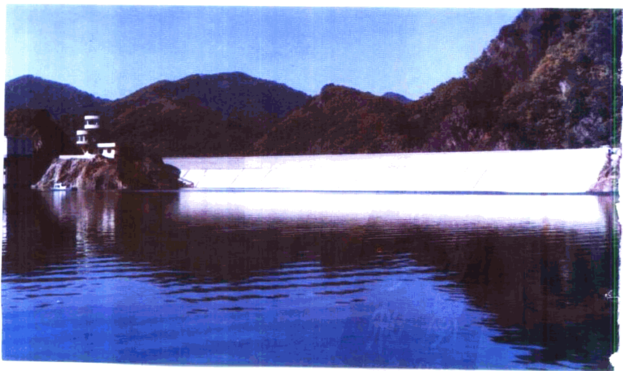
关门山混凝土面板堆石坝
