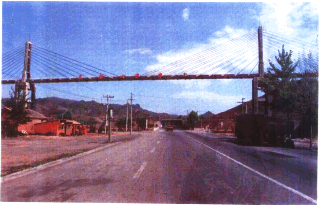
北京市的斜拉渡槽
