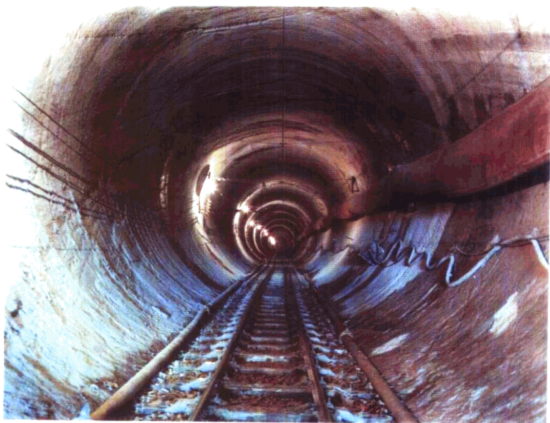
引滦入津隧洞工程在施工中
