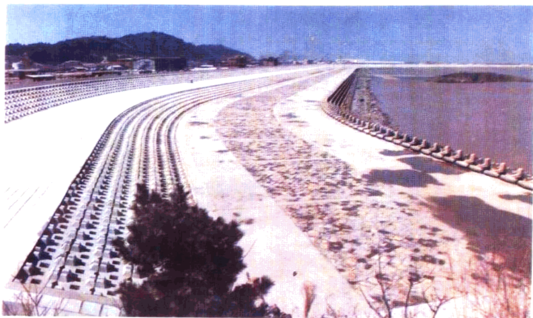
秦山核电厂海堤
