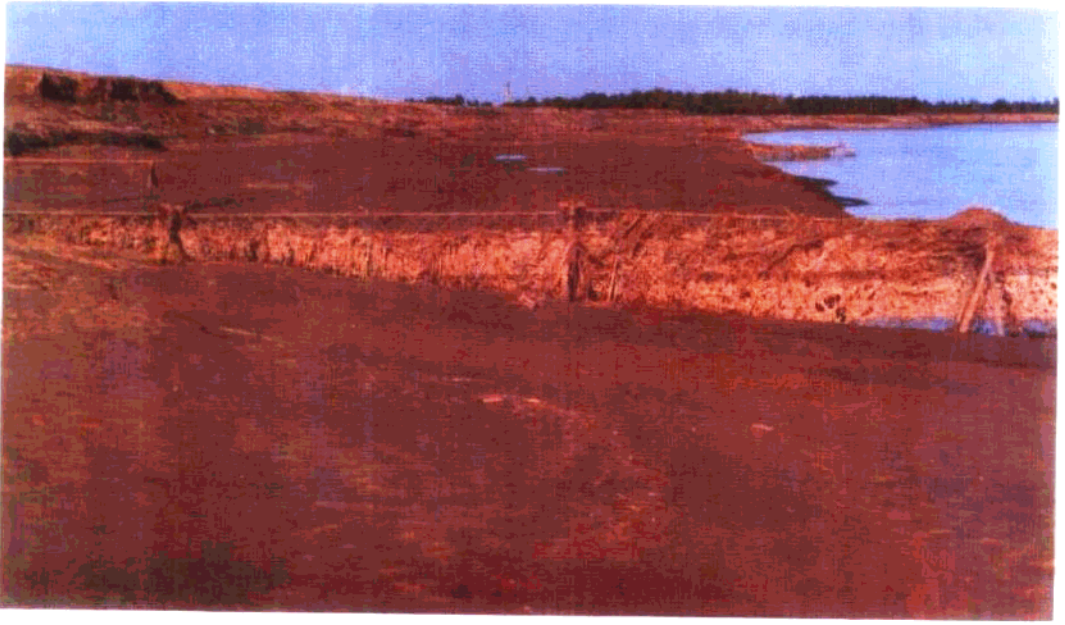
黄河新河口钢管网坝护堤工程
