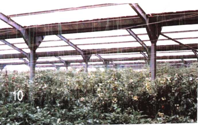
大型钢骨架温室
