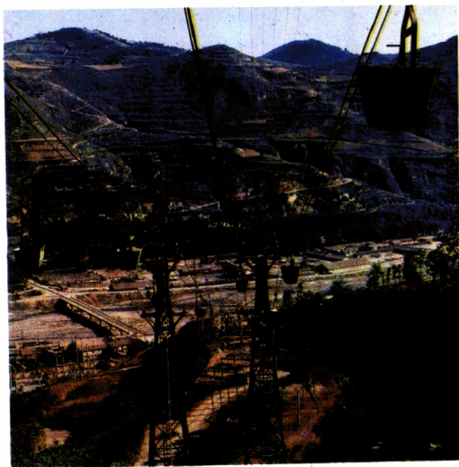
施工中的洛河故县水库
