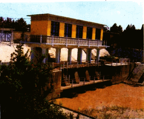
开封黑岗口引黄供水闸
