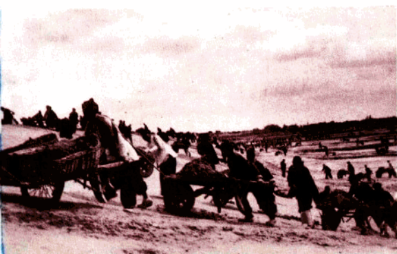
建国初期土碓工筑堤
