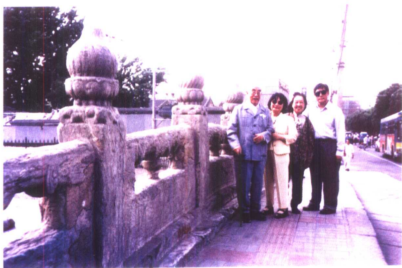
修复后的万宁桥（东侧石栏）
