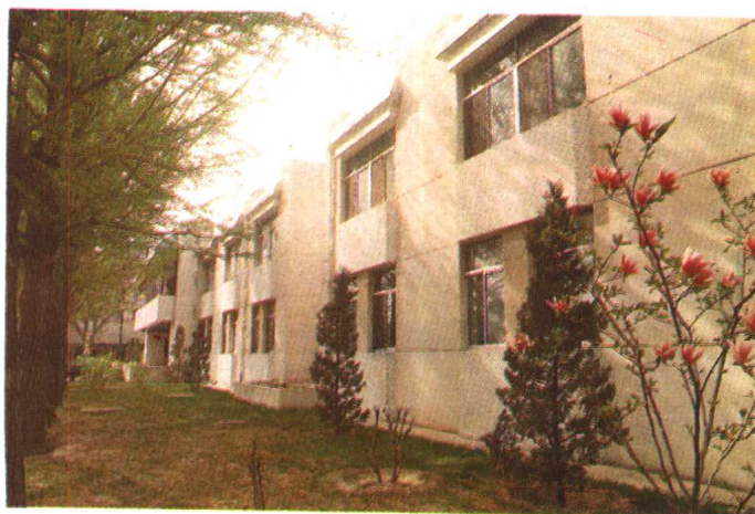
生物制品检定楼
