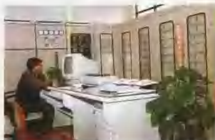
110千伏变电站微机集控设备
