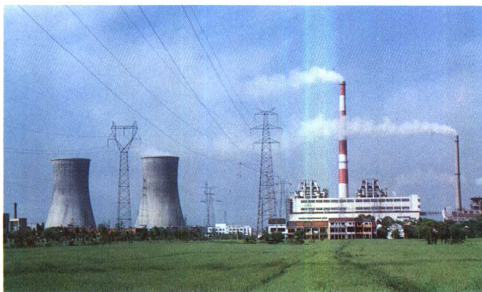
戚墅堰電廠改擴工程一期工程2台20萬千瓦發電機組建成投產
