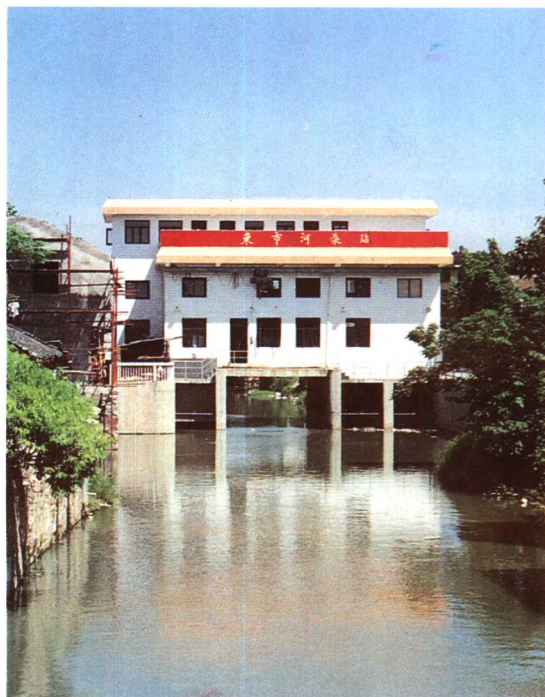
市區防洪系統之一的東市河泵站
