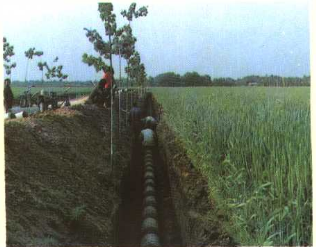
夏县示范区正在铺设混凝土 低压输水管道
