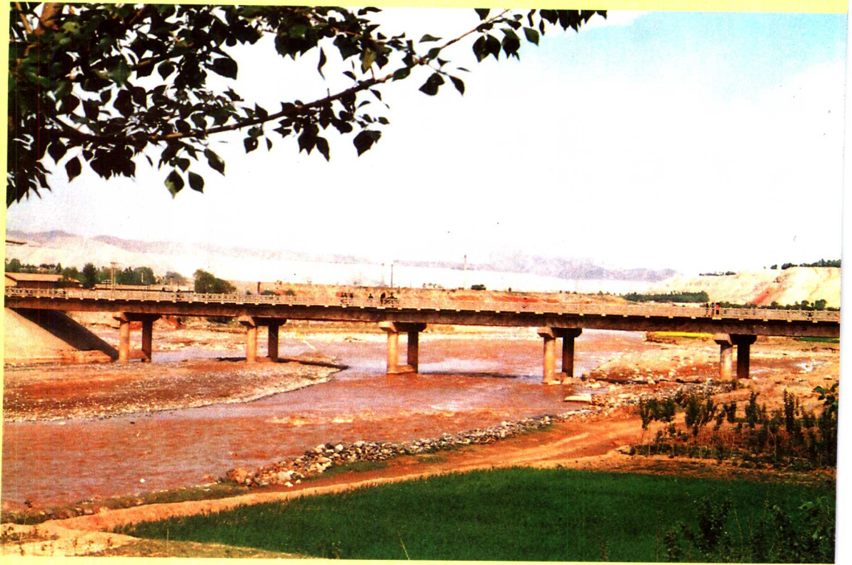
湟水(享堂)大桥
