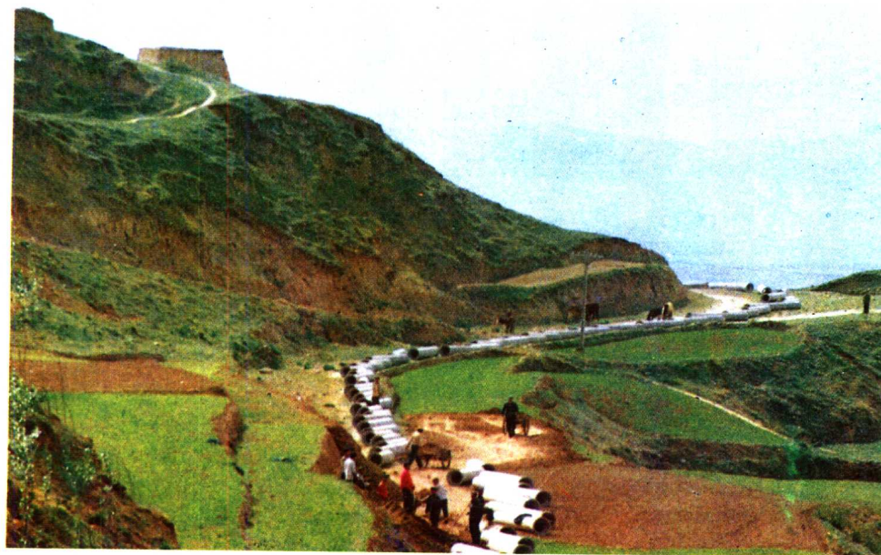
2708—8 项目东沟管道工程
