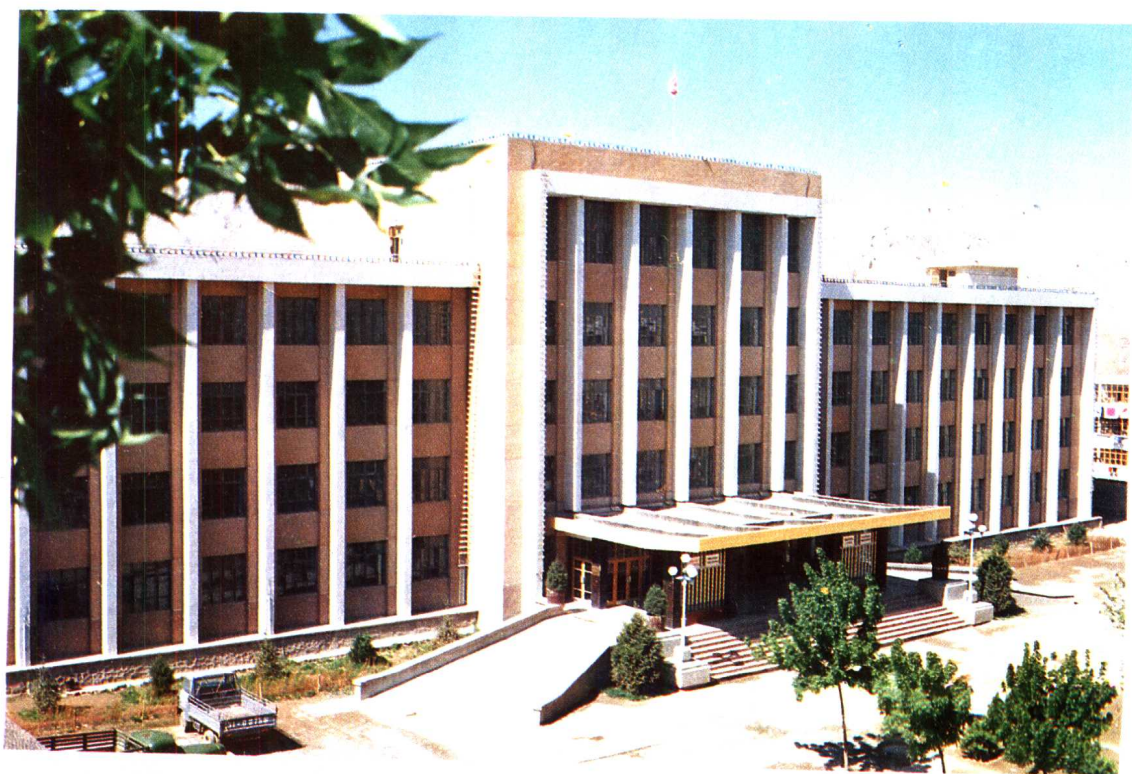
县人民政府办公楼
