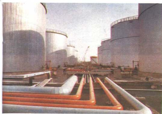
建设中的新疆乙烯工程
