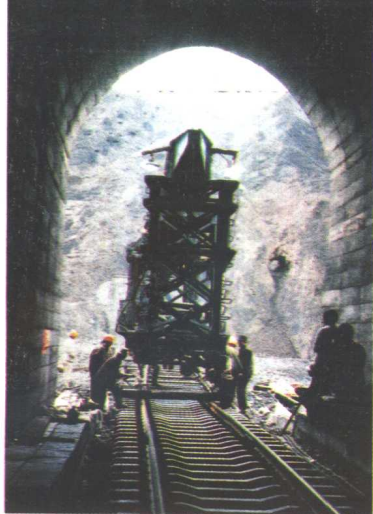
架桥机在天山 隧道里作业
