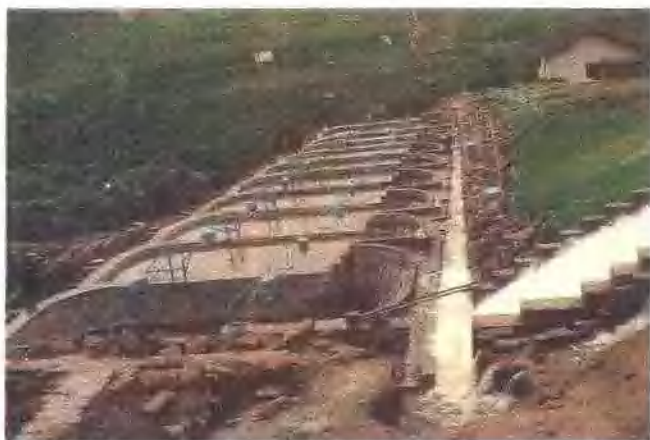
永川上游水库流水养鱼池在充水
