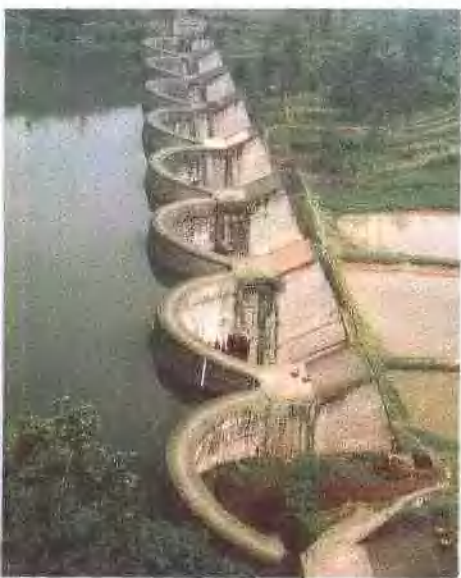
永川革命水库 倾斜式砌石连拱坝
