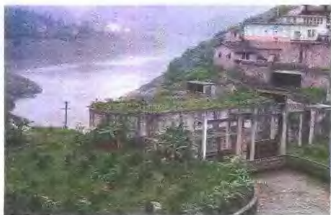
长寿运输桥水电站淹没式厂房
