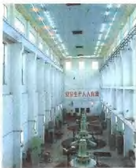
潼南三块石水电站主厂房
