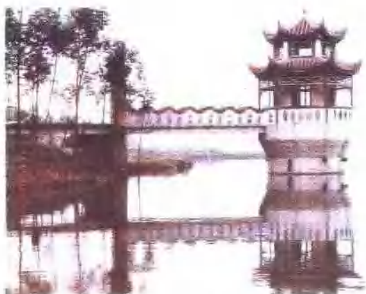
合川双河水库云官干渠取水塔
