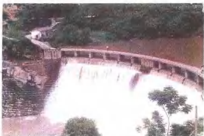
北碚澄江运河砌石拱坝
