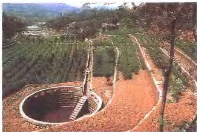
铜梁水土保持综合治理
