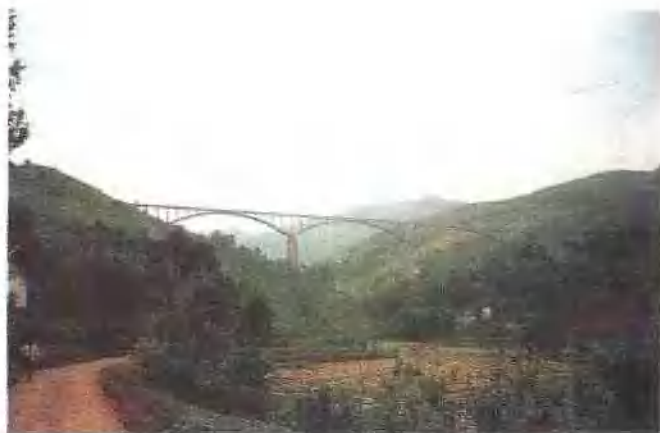
江北县胜天水库小桥渡槽
