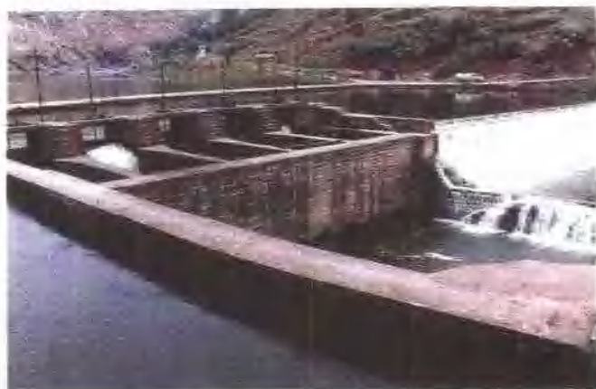
长寿运输桥水轮泵站
