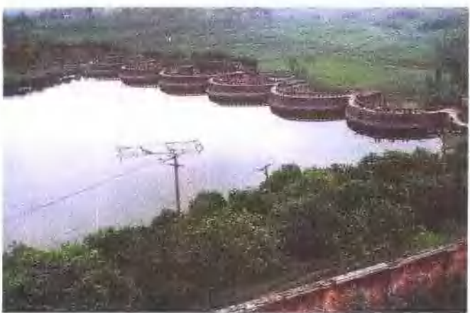
永川东方红水库砌石连拱坝
