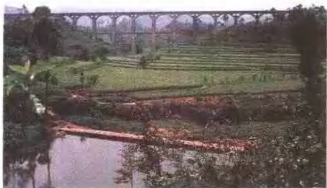
永川牛门口水库双层渡槽
