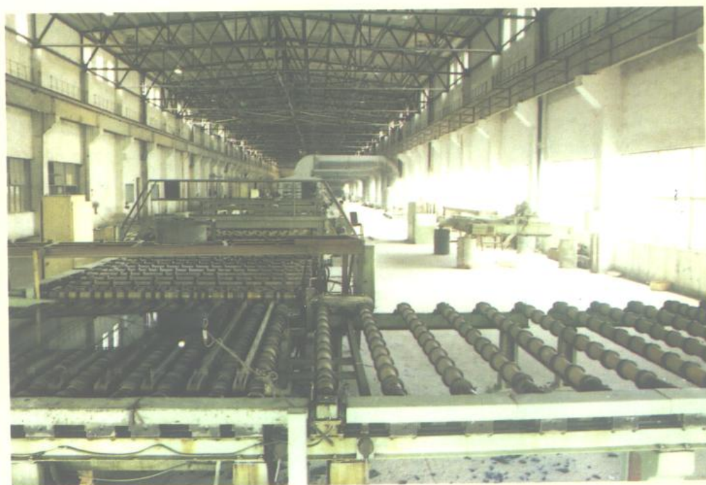
浮法玻璃总公司生产线
