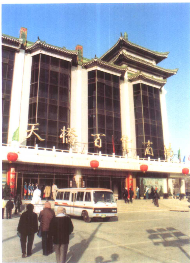
彩图 5 北京市天桥百货商场以双色塑料窗框配蓝灰色中空玻璃组装凸形玻璃幕墙 [(6600\text{mm} \times 13500\text{mm}) \times 17\text{组}]
