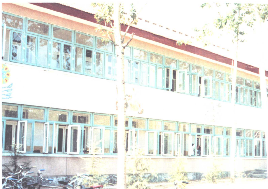
彩图1 连云港市东海幼儿园采用双色型材制作的带形组合窗 (60000mm × 1800mm )
