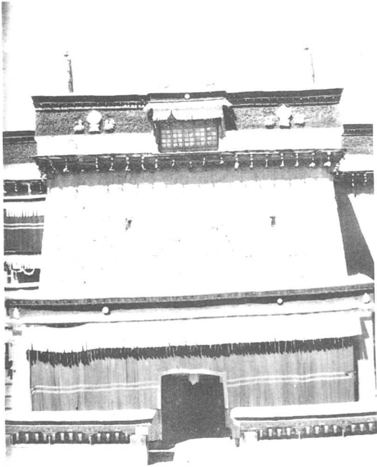
图版十五 萨迦南寺拉康钦莫殿建筑局部
