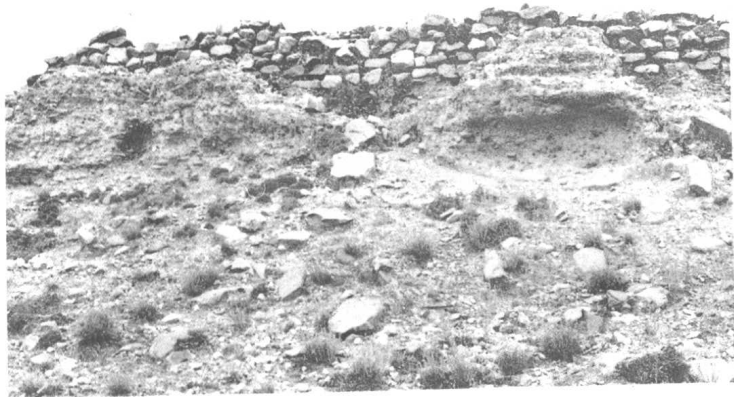
图版五 吉龙堆古墓群 M 125封土夯墙及石网墙
