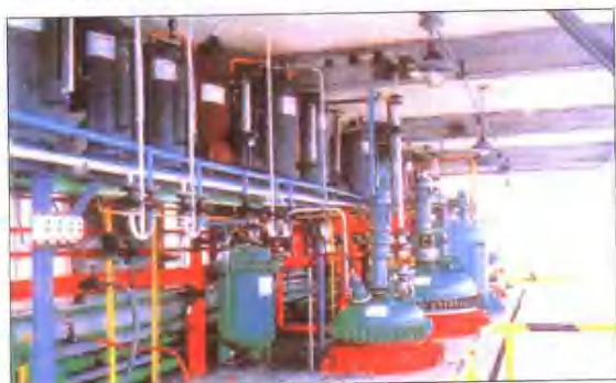
江苏绿利来股份有限公司乙草胺生产车间一角
