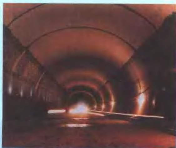
▲成渝高速公路龙泉山隧道
