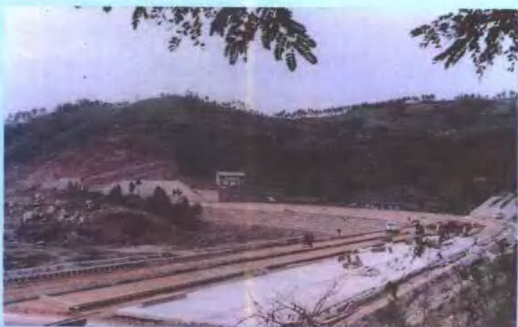
▲新建成渝高速公路成简段正在施工
