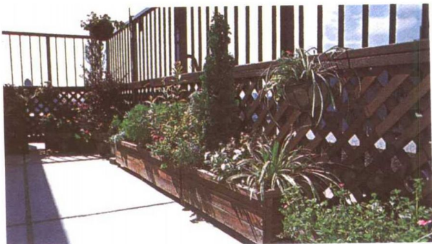
东边栏杆的下半部分安装格子篱，花盆全部套在杉木做成的套盆中
