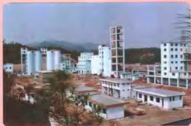
正在兴建中的中外合资企业——东南回转窑水泥生产厂
