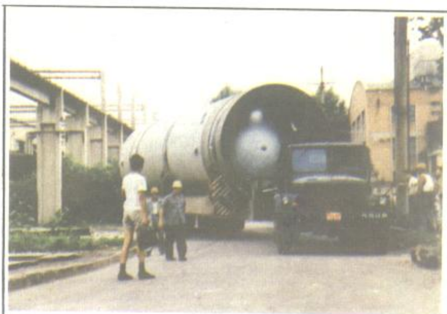
空分设备厂生产的大型液氮槽运输出厂
