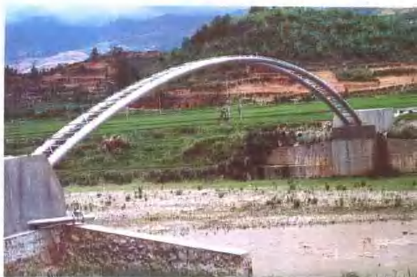
▲正觉庵水库北倒跨河工程（郭家伦 摄）
