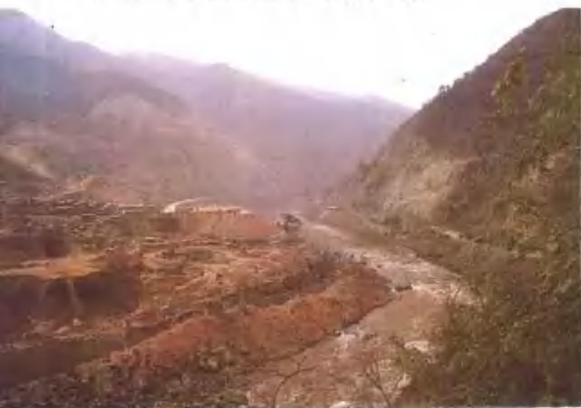
▼大朝山水电站建设工地（郭家伦 摄）
