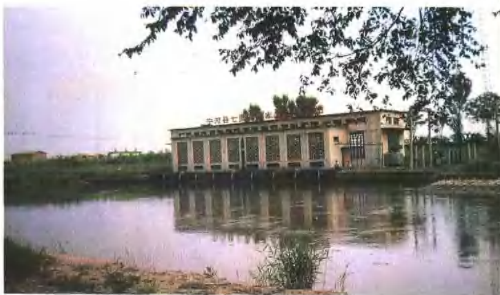
七里海水库 第二扬水站
