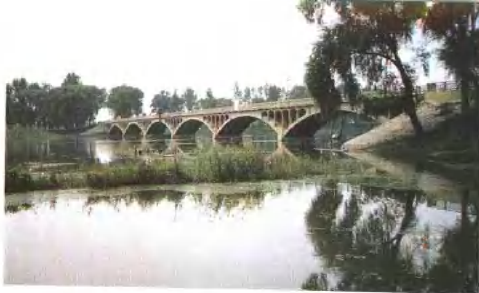
蓟运河埋珠 双曲拱生产桥
