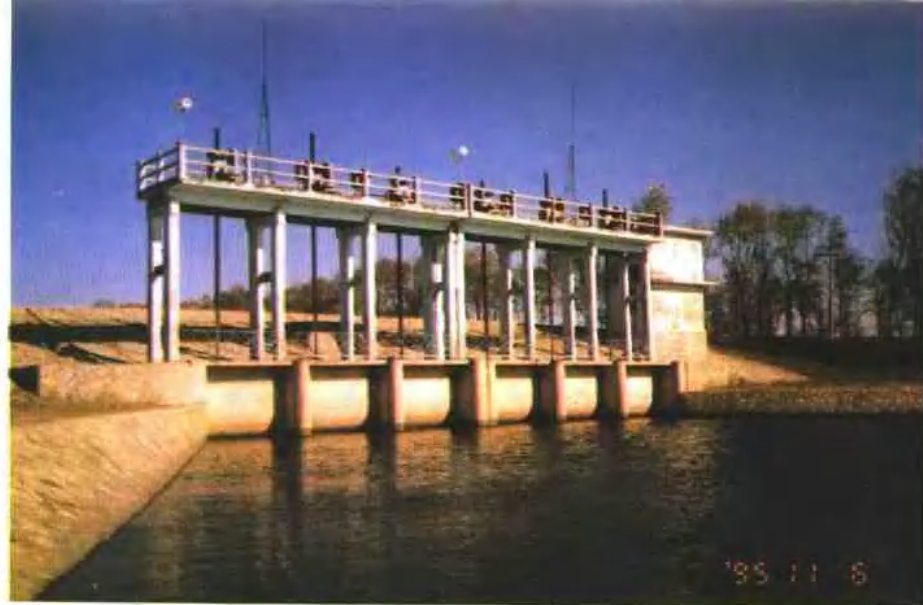
小新河 西魏防洪闸
