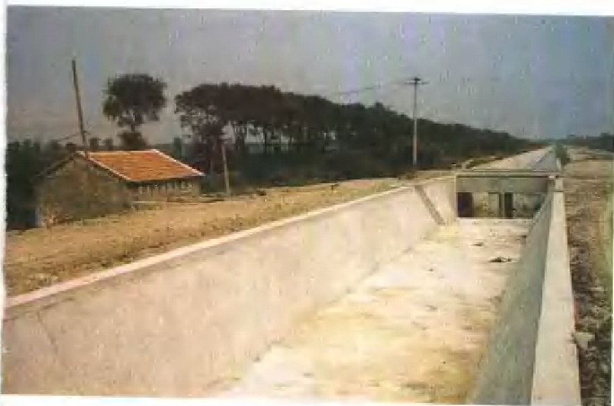
苗庄乡 防渗渠道 水稻万亩园区
