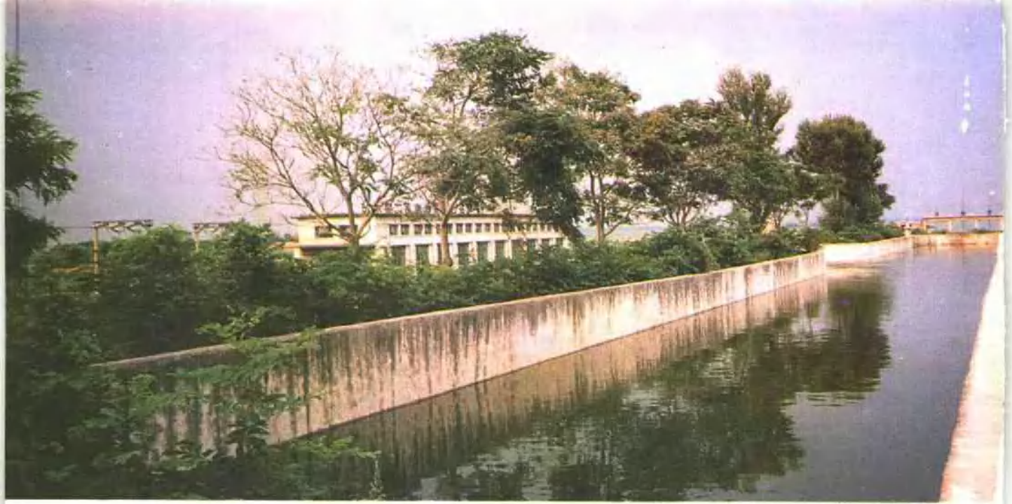
七里海水库扬水站上水渠道
