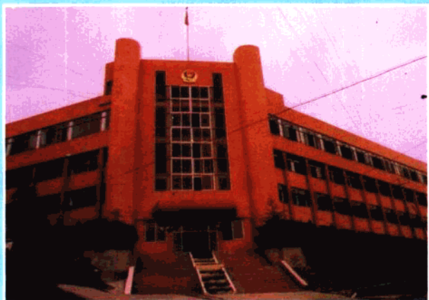
△市局公安学校教学大楼外貌
