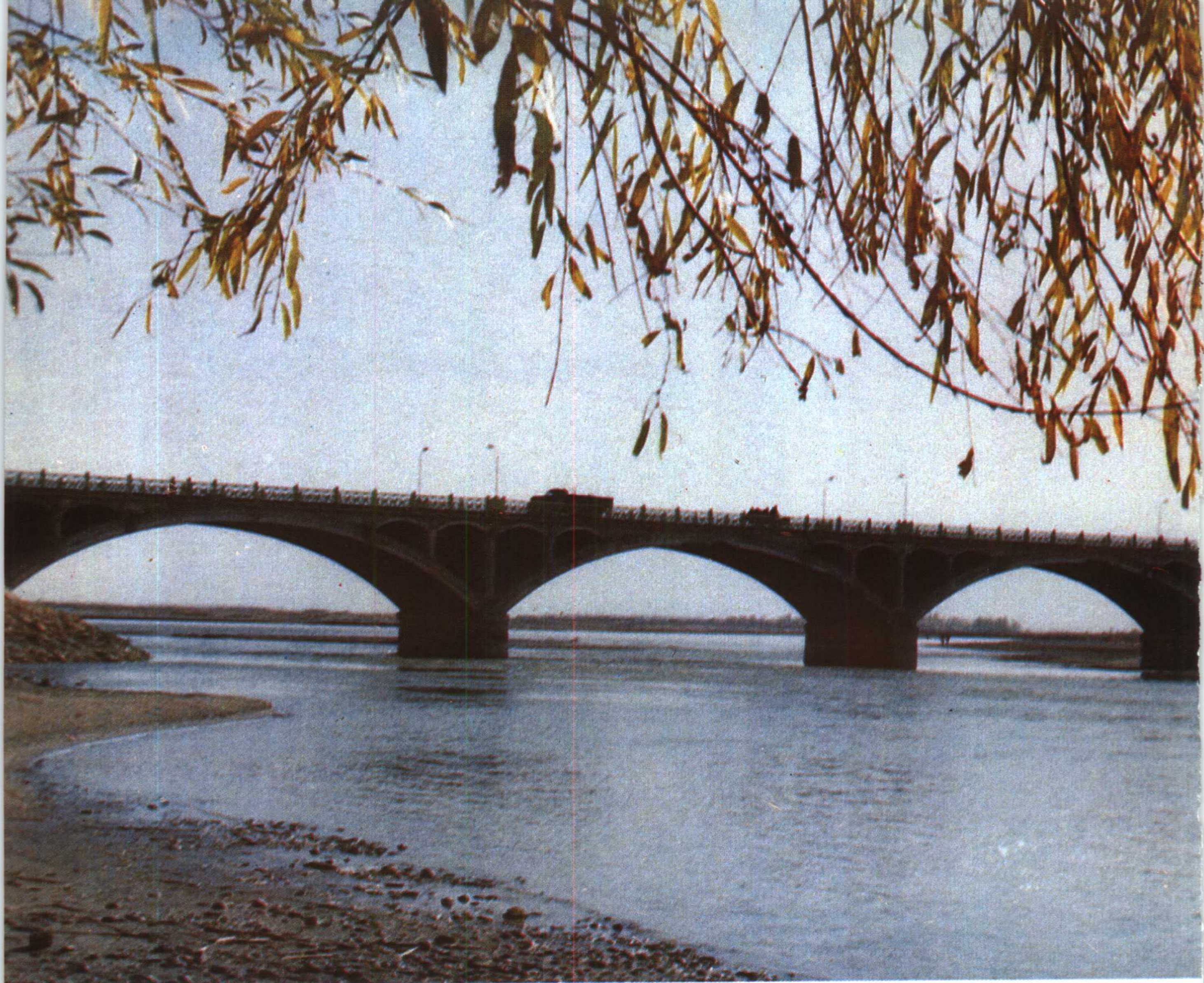
伊犁河大桥——察布查尔县的门户， 于1972年建成，长300米，宽7米，承重15 吨。
