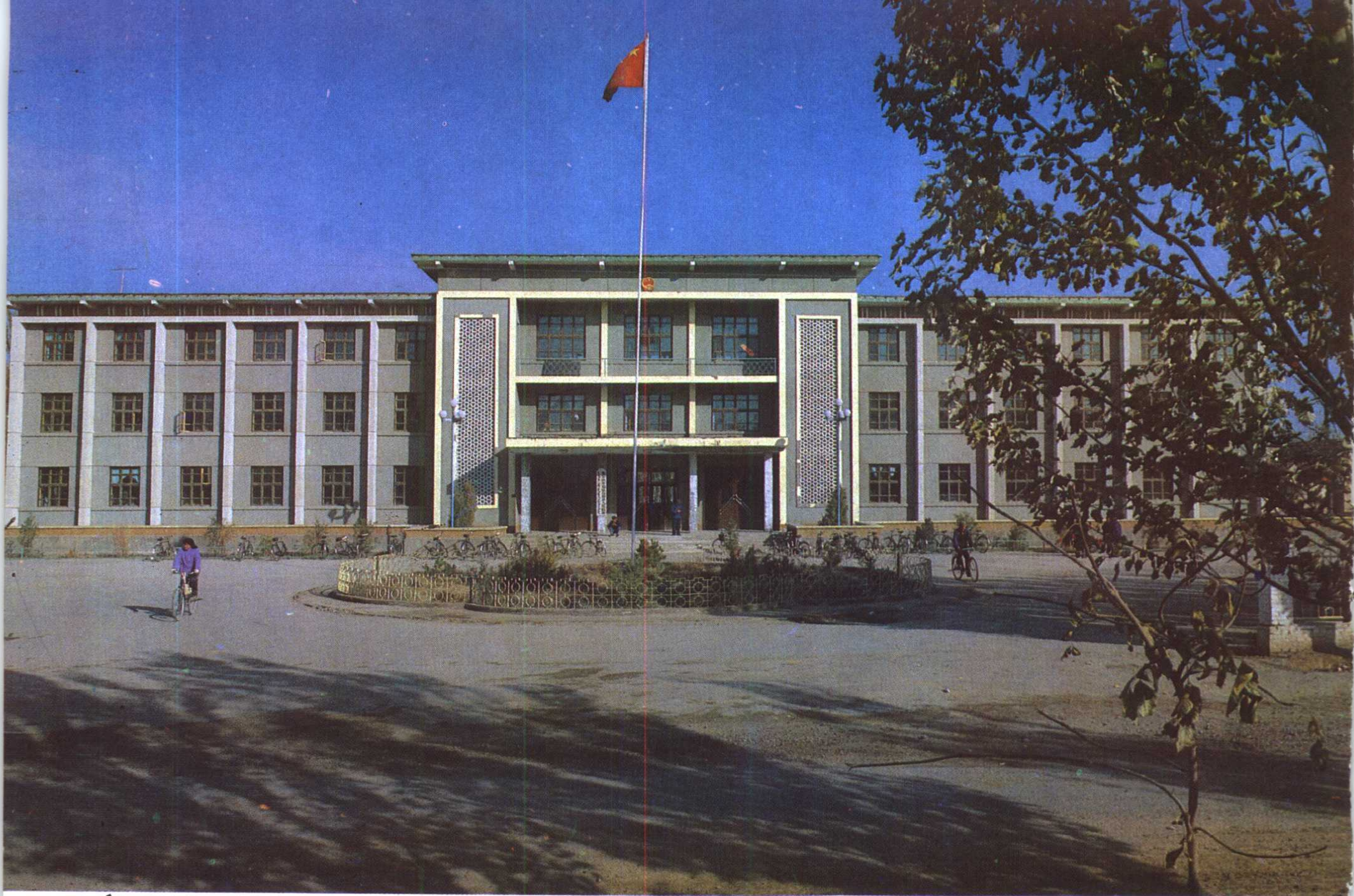
县人民政府办公楼
