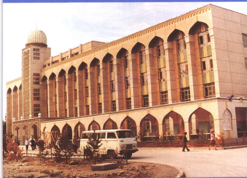
△新疆维吾尔自治区维吾尔医医院门诊大楼
