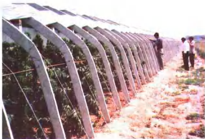
GRC日光温室外部
