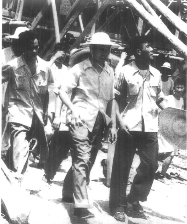
1958年7月15日，周恩来在上海第三钢铁厂扩建 工地视察。
