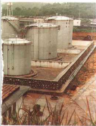
工产品仓库罐区 (1990年)
