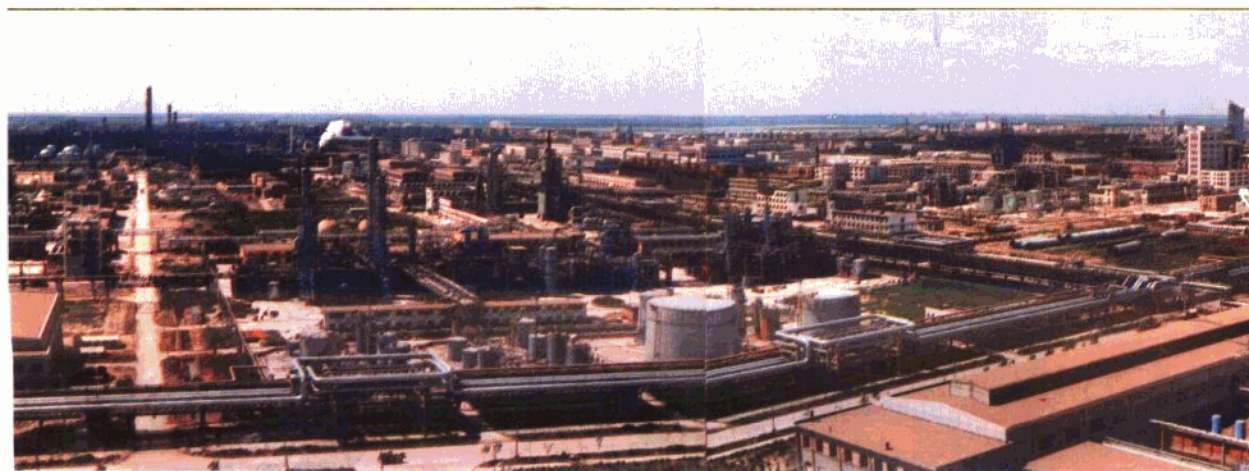
▽ 大庆三十万吨乙烯工程全景
