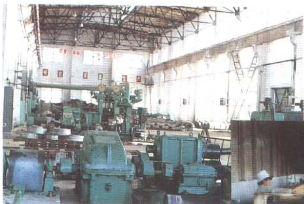
白塔堡镇小羊安村 办工厂车间内景
