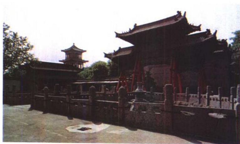
木牌坊与泮池
