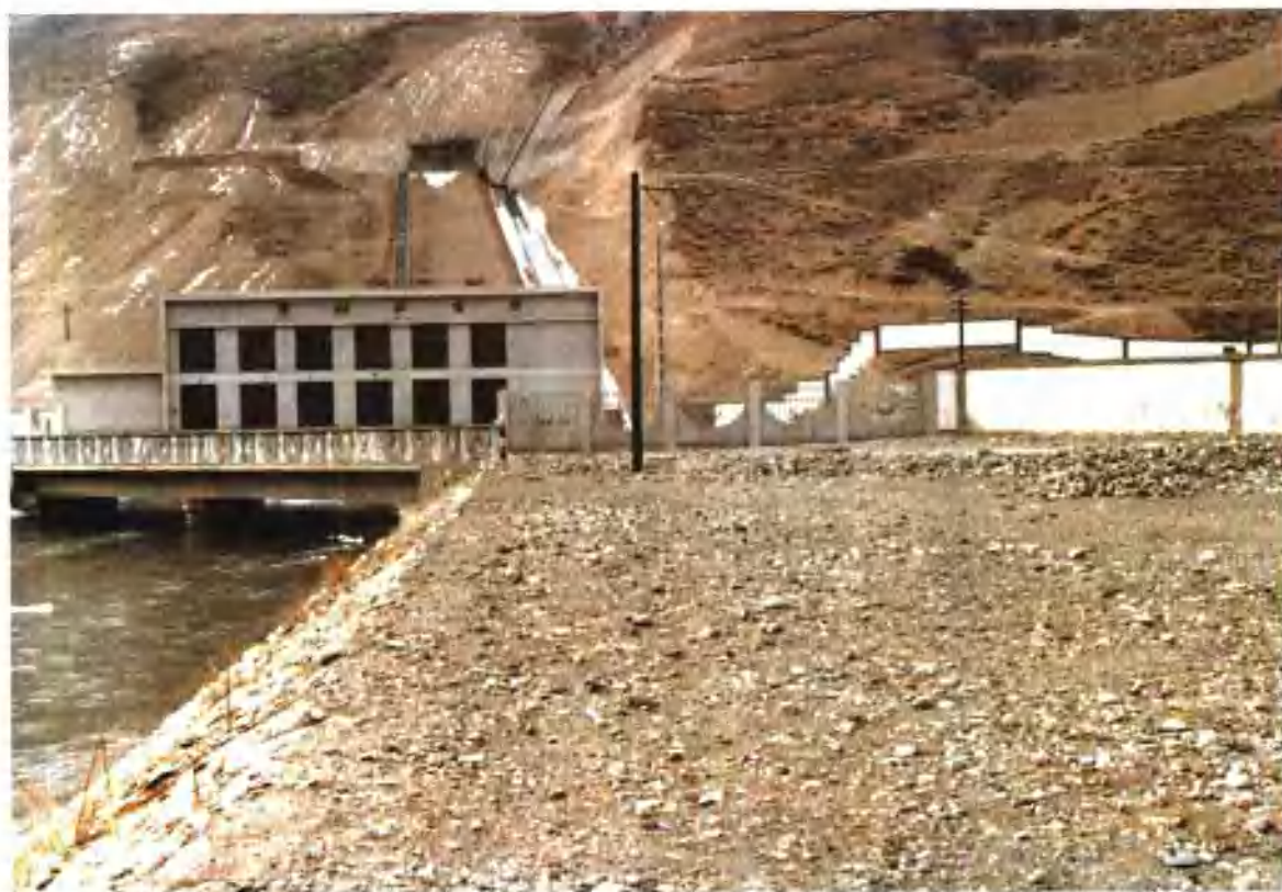
22 玉树藏族自治州3×1250千瓦西杭水电站(海拔3750米)
