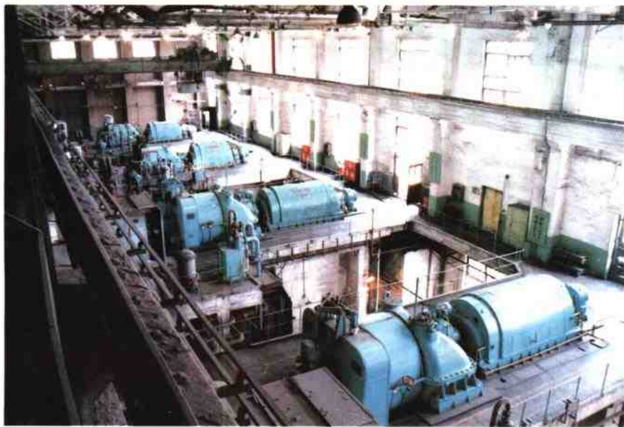
10 桥头发电厂 2 \times 6000 千瓦 及 2 \times 1.2 万千瓦汽轮发电 机组
