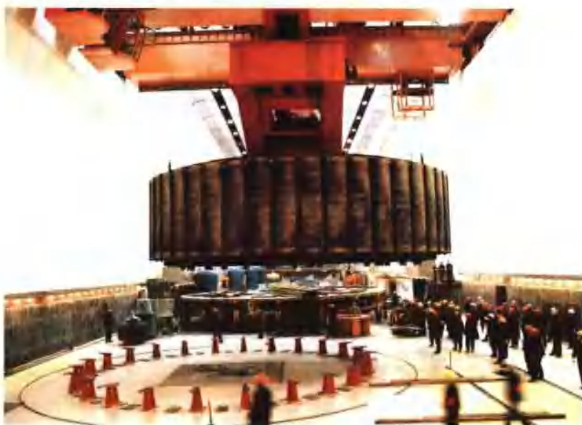
19 龙羊峡水电厂32万千瓦机组检修
