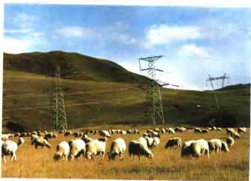
32 草原上的330千伏线路
