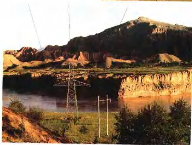
33 第一条跨越黄河的110千伏 线路—朶李线
