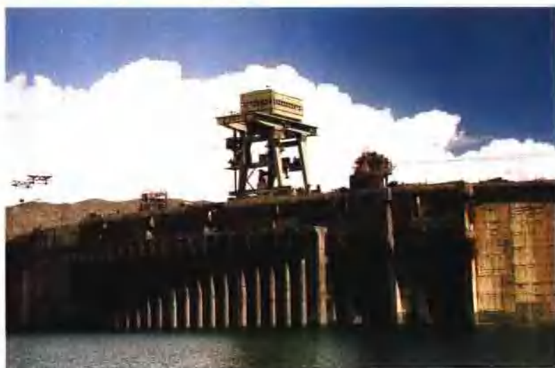
16 龙羊峡水库大坝(坝高178米)
