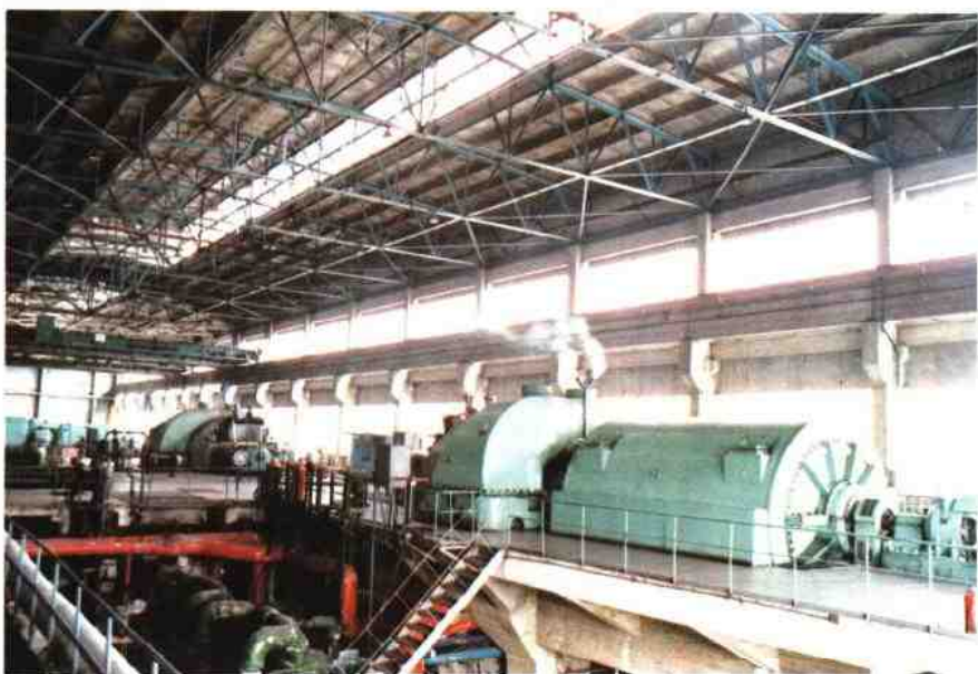
11 桥头发电厂 2 \times 2.5 万千瓦及 2 \times 5.0 万千瓦汽轮发电机 组
