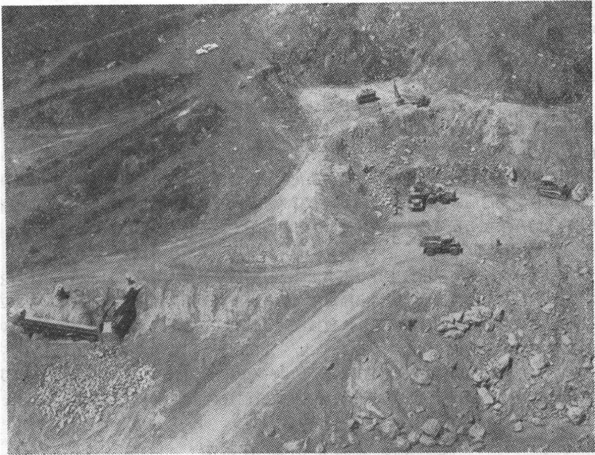
图 3 新梅隆斯坝的试验采石场和格筛
