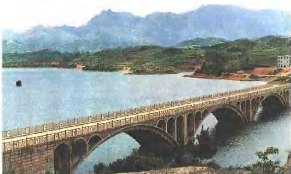
紫荊公路大桥
