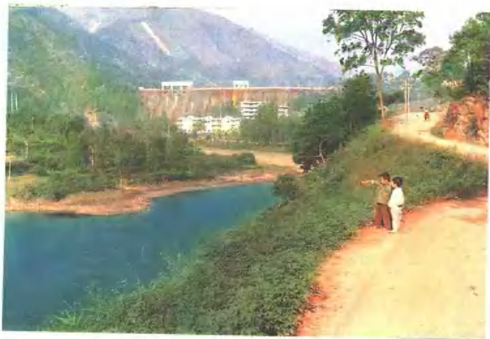
金田水库（电站）坝首
