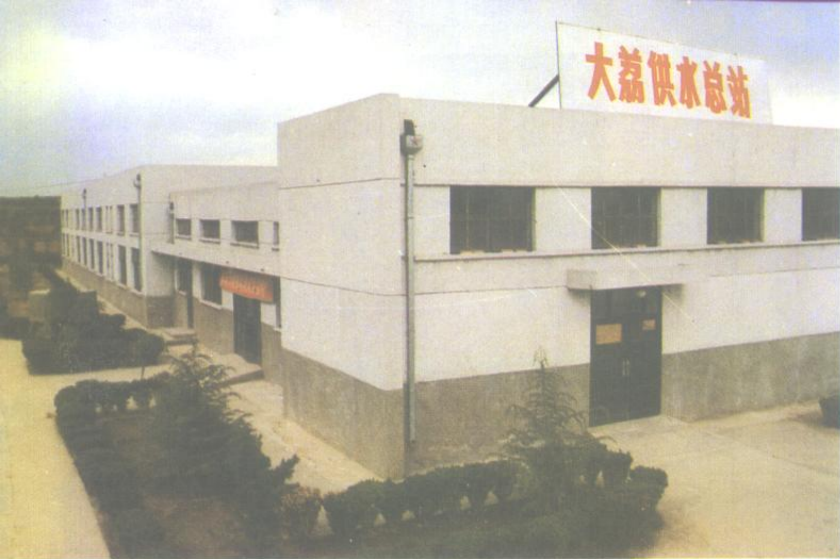
大荔供水总站
