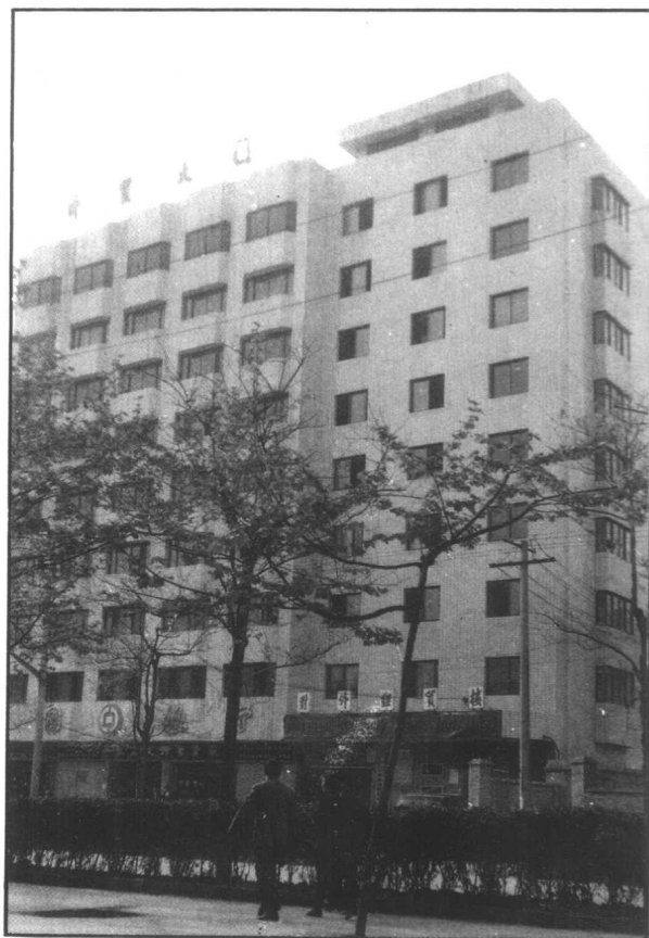
黔东南州对外经济 贸易综合办公大楼
