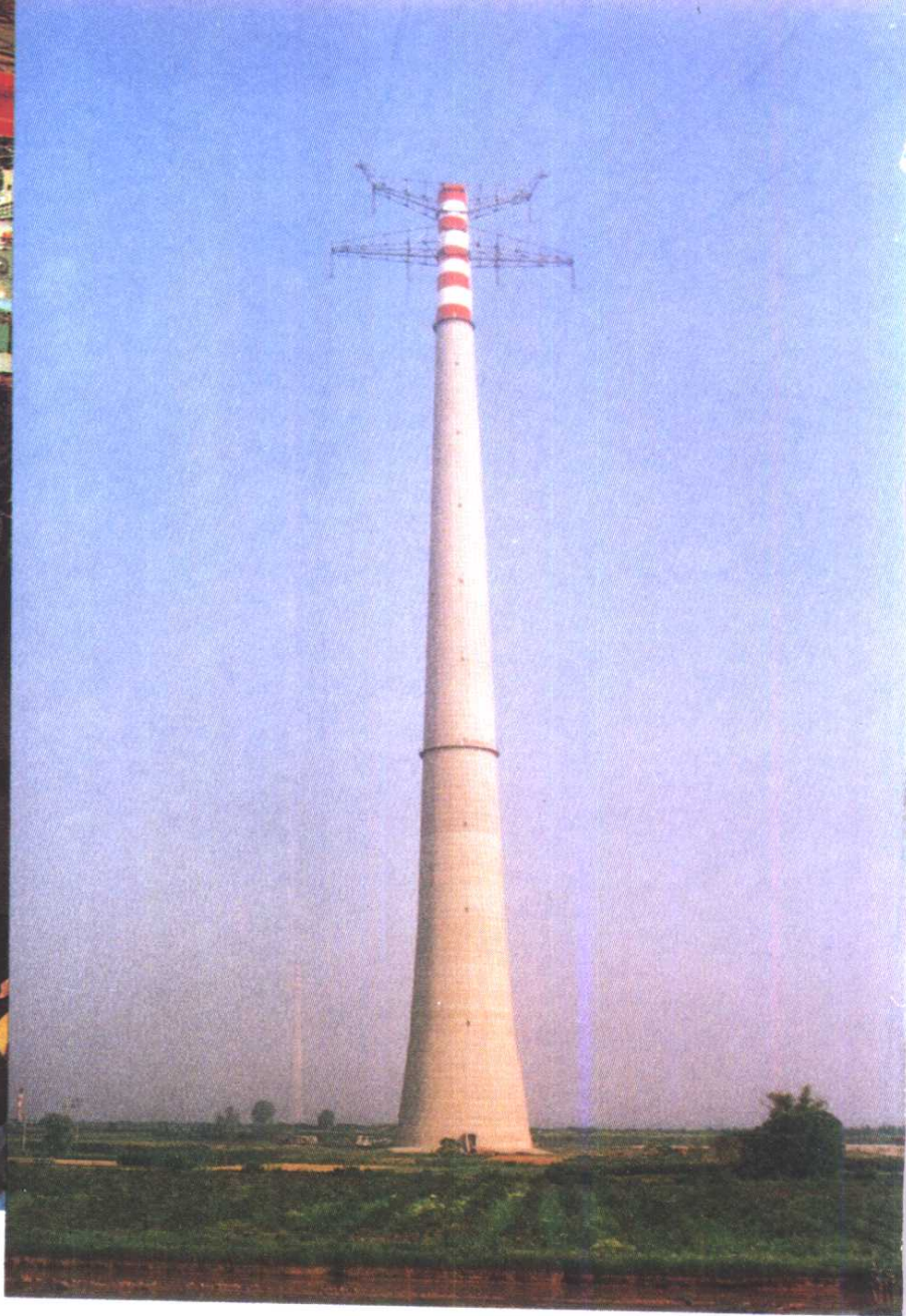
地处大胜关的世界最高钢筋混凝土结构 大跨越过江输电塔(十七冶二公司承建)
