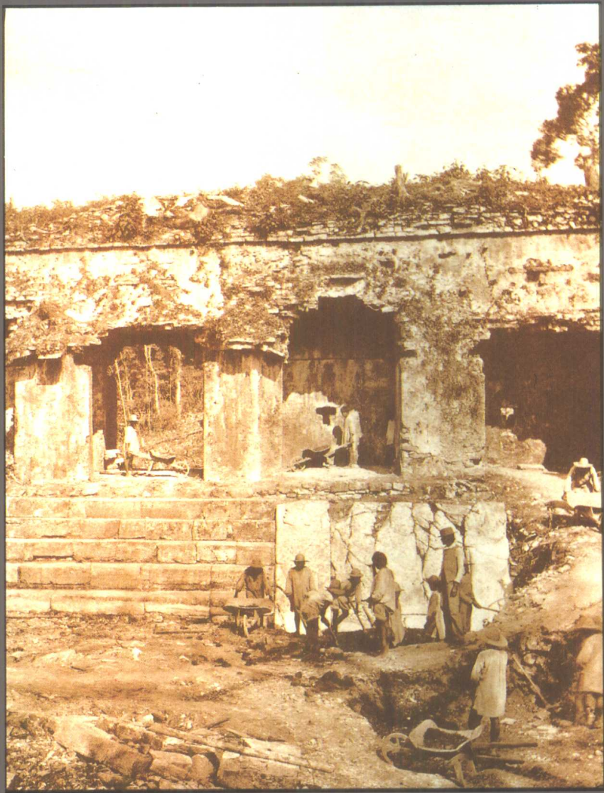
“这座建筑物位于宫殿台基东半部的北面， 包括两条平行的走廊，中间有一道主墙隔开。”
