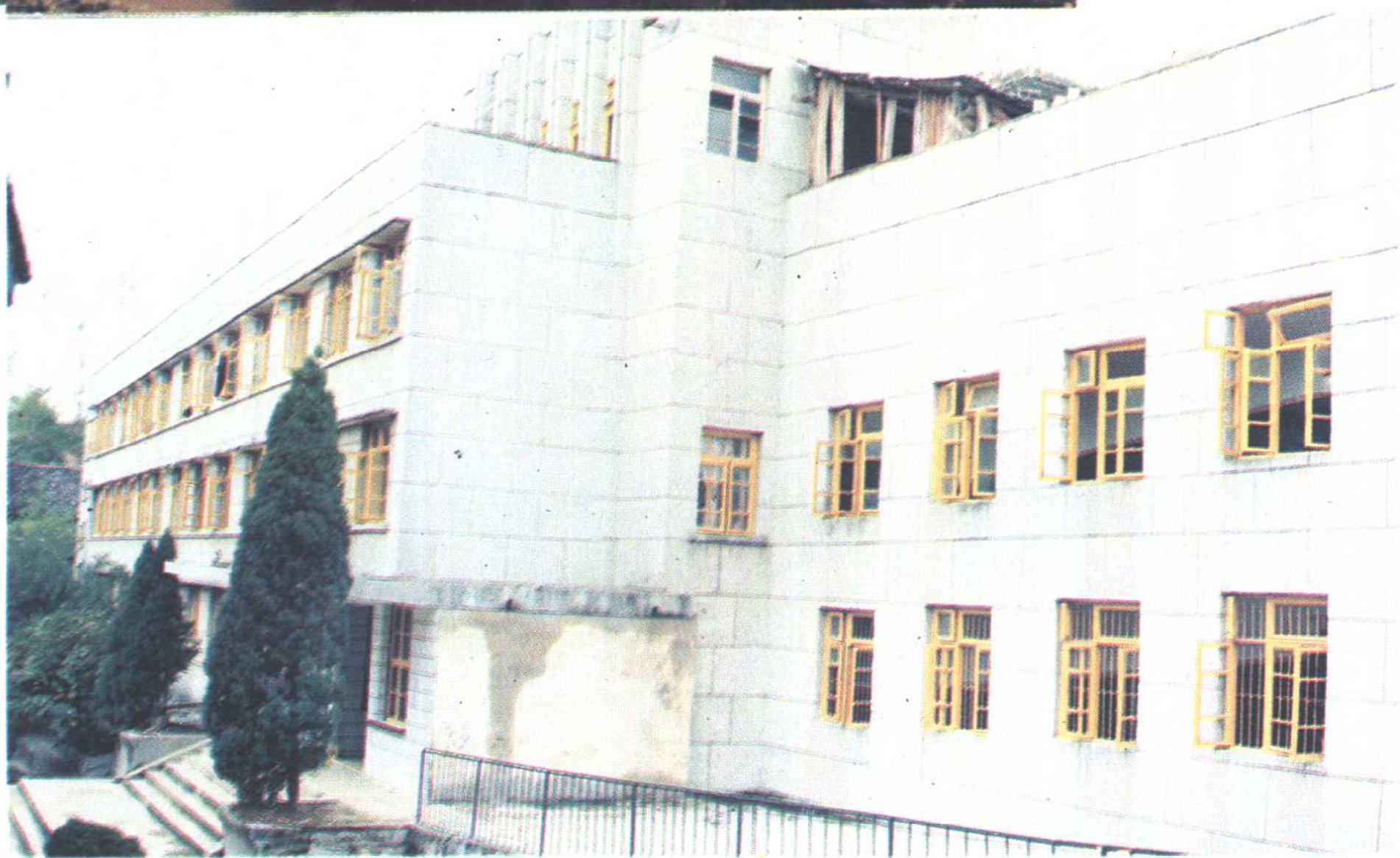
→ 县人民医院住院部
