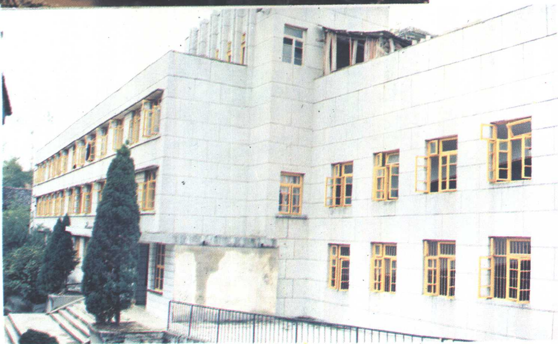
→ 县人民医院住院部
