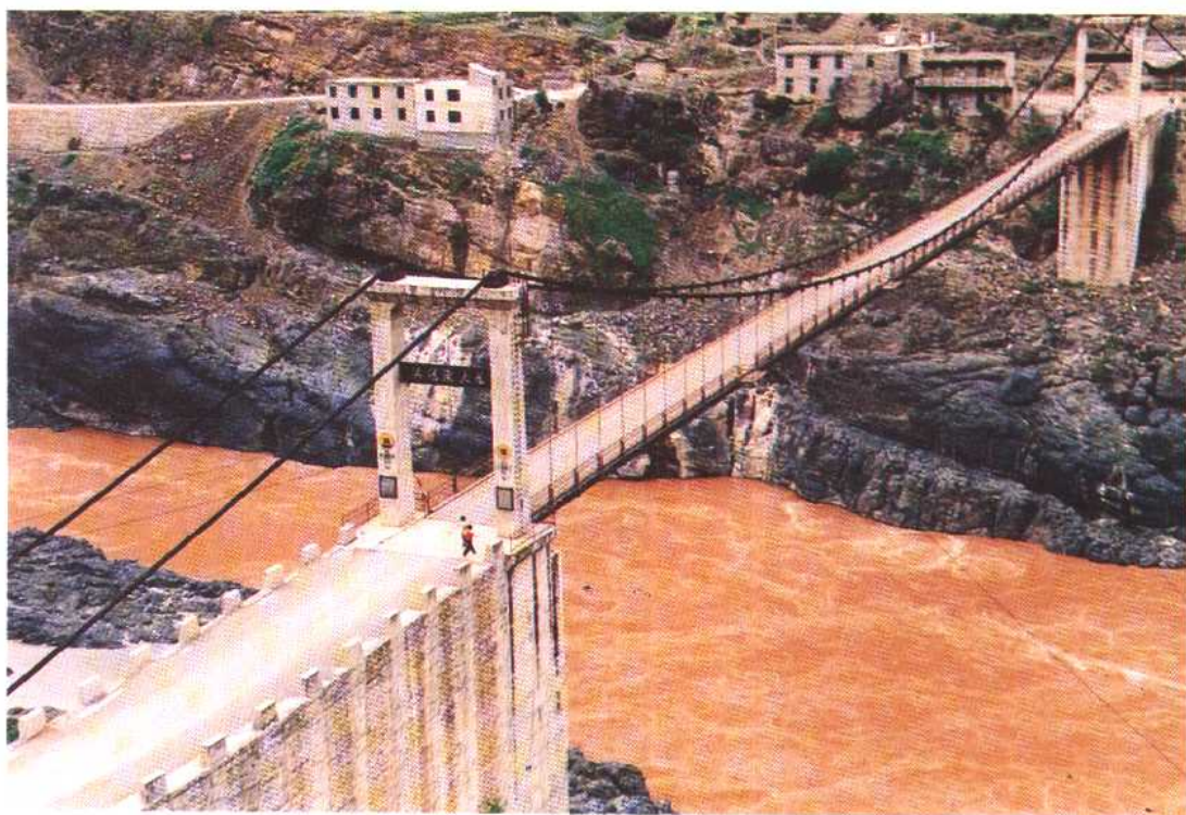
1.金沙江溪落渡大桥 (赵明 摄)
