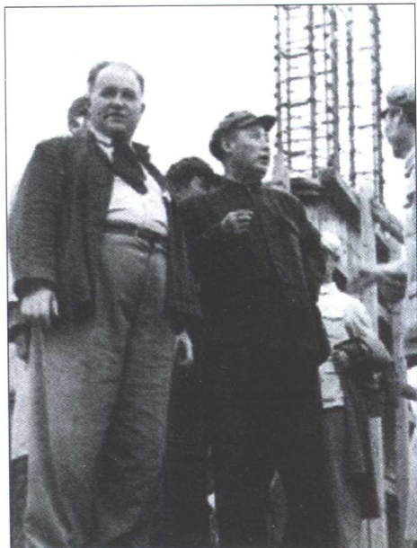
水利部长傅作义和苏联水利专家布可夫视察荆江分洪工程工地
