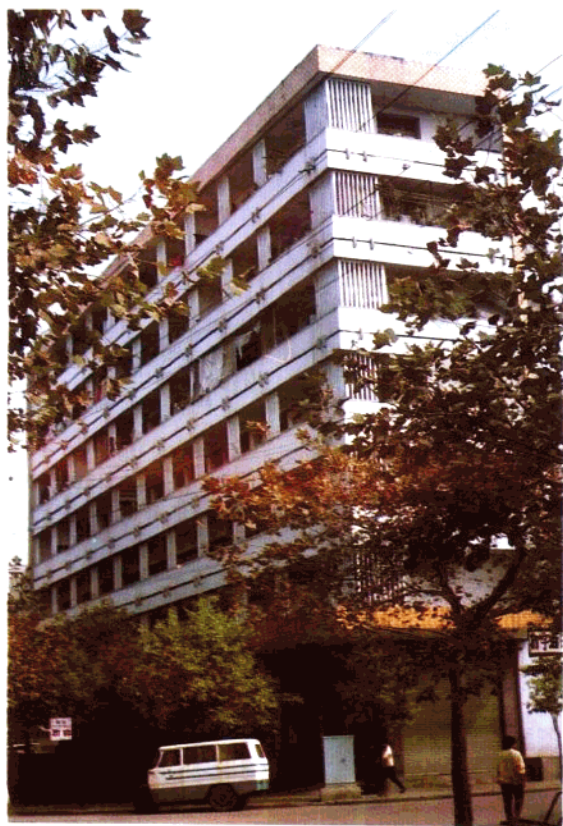
州生产资料服务公司办公大楼
