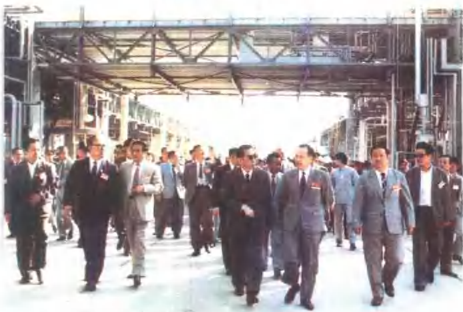
1984年6月 国务委员康世恩（右四），中共山东省委副书记姜春 云（左六）视察齐鲁石化建设工程公司齐鲁石油化工公司施工工地
