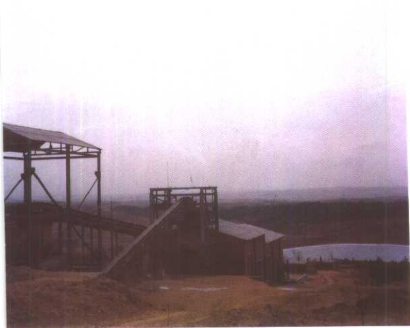
▽ 王滨沟乡尖山子铁矿破碎车间
