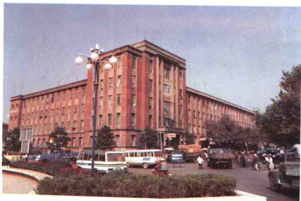
▲ 1962 年全部竣工的株洲市邮电局局屋（建设中路 8 号）
