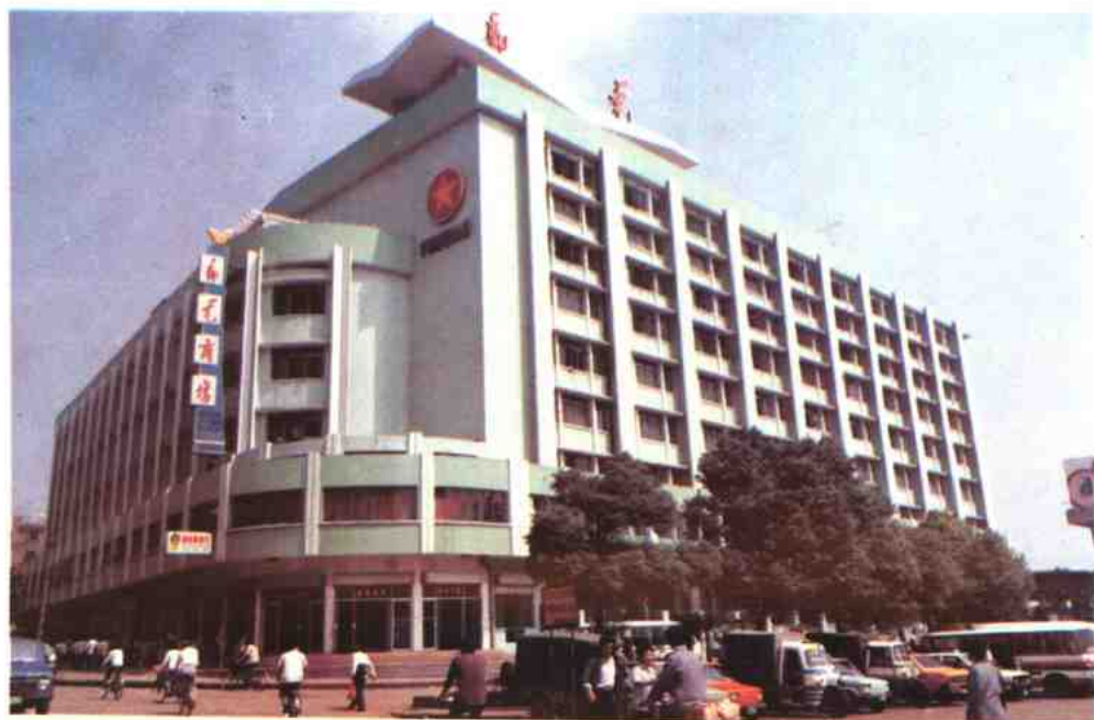
▲ 1988 年落成的邮政转运大楼
