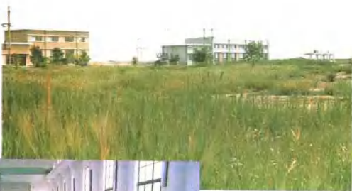
东沽排污泵站
