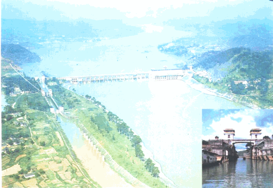
郛江西津水电厂装机23.44万千瓦。
