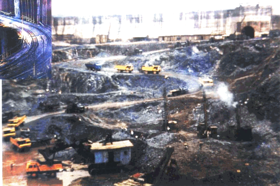
1978年大化水 电站开挖基坑。
