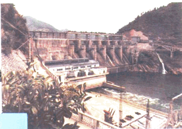
贺江合面狮水电站装机 4 \times 1.7 万千瓦
