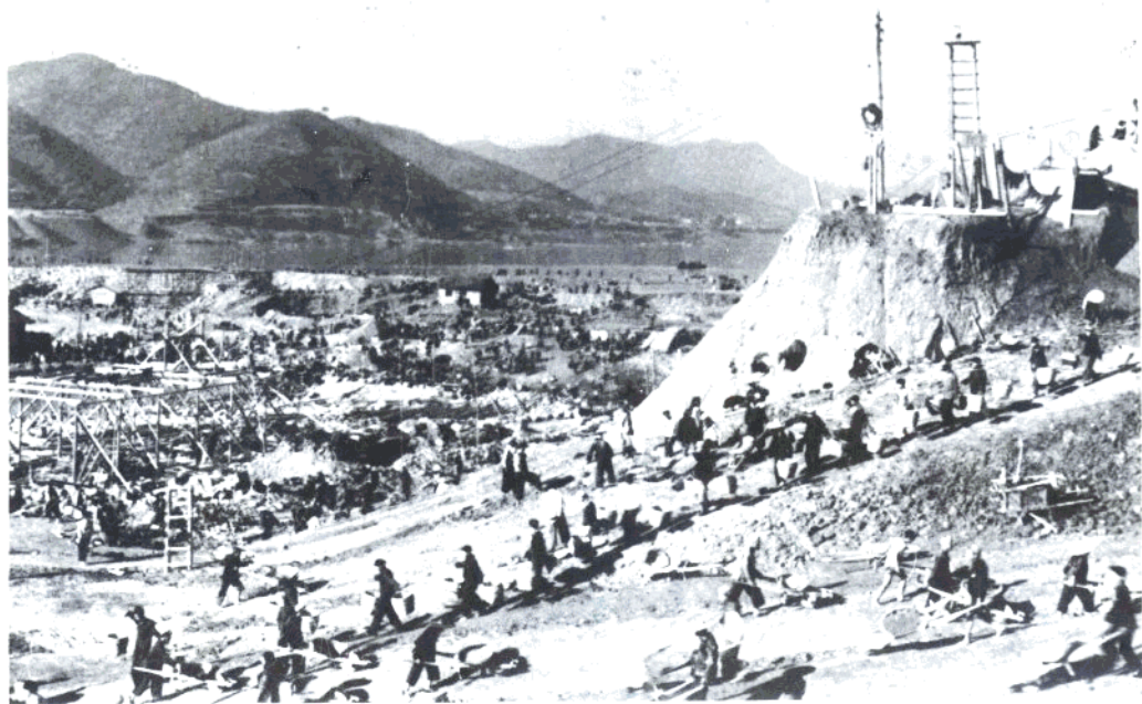
1959年西津水电站一期土石木 笼高水围堰施工。（杜志明提供）
