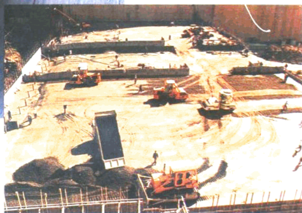
岩滩水电站工地隧道正 是混凝土施工，日浇筑量为 15米，日浇筑强度8189二 米，达到国际先进水平。
