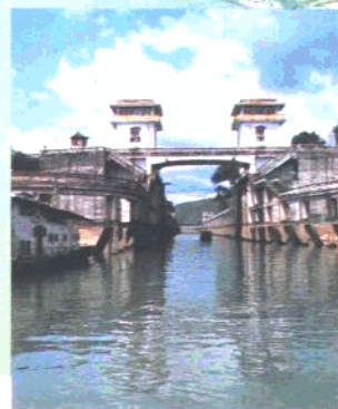
西津水电厂通航船只。
