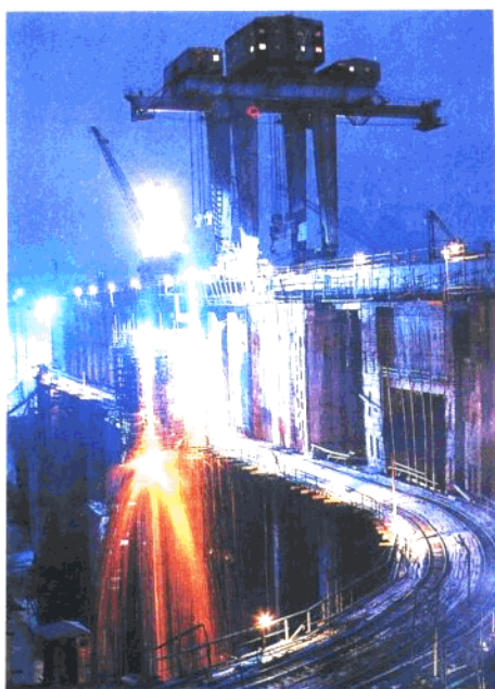
1982年大化水 电站施工夜景。
