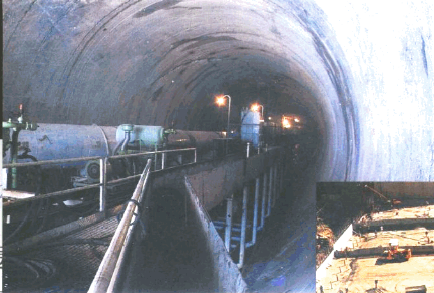
天生桥水电站工地引进美 国10.8米全断面掘进机进行隧 洞开挖。
