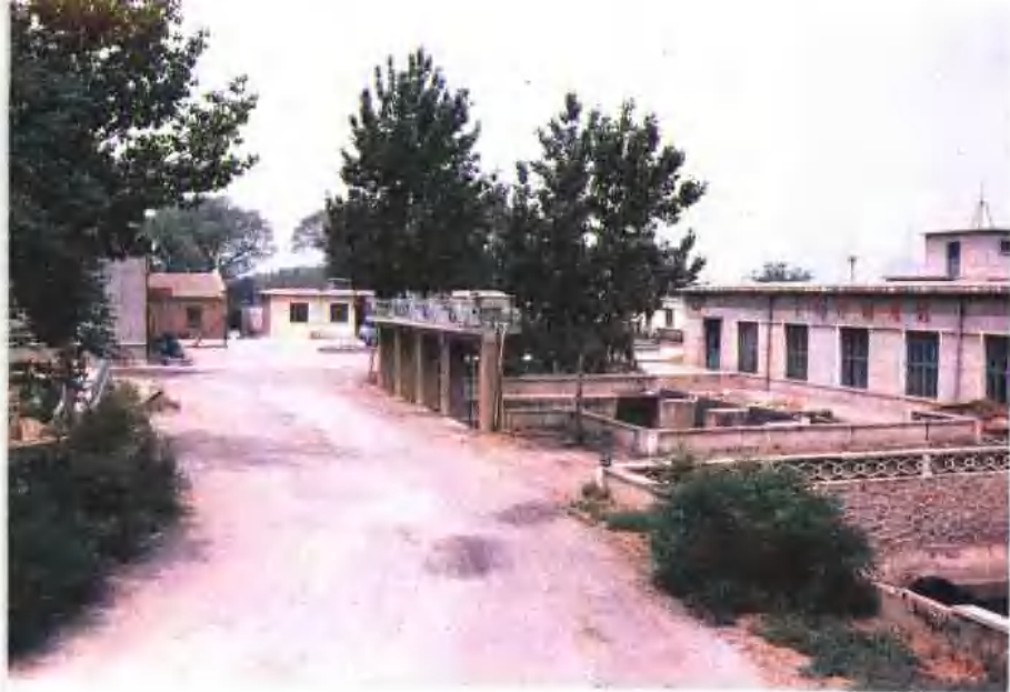
中心桥扬水站
