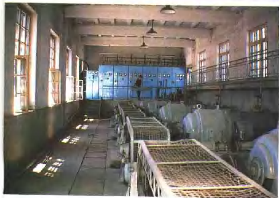
中心桥扬水站机房
