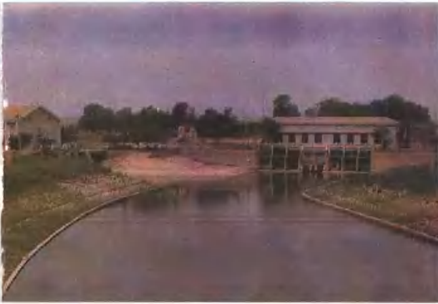
潮白新河引水泵站
