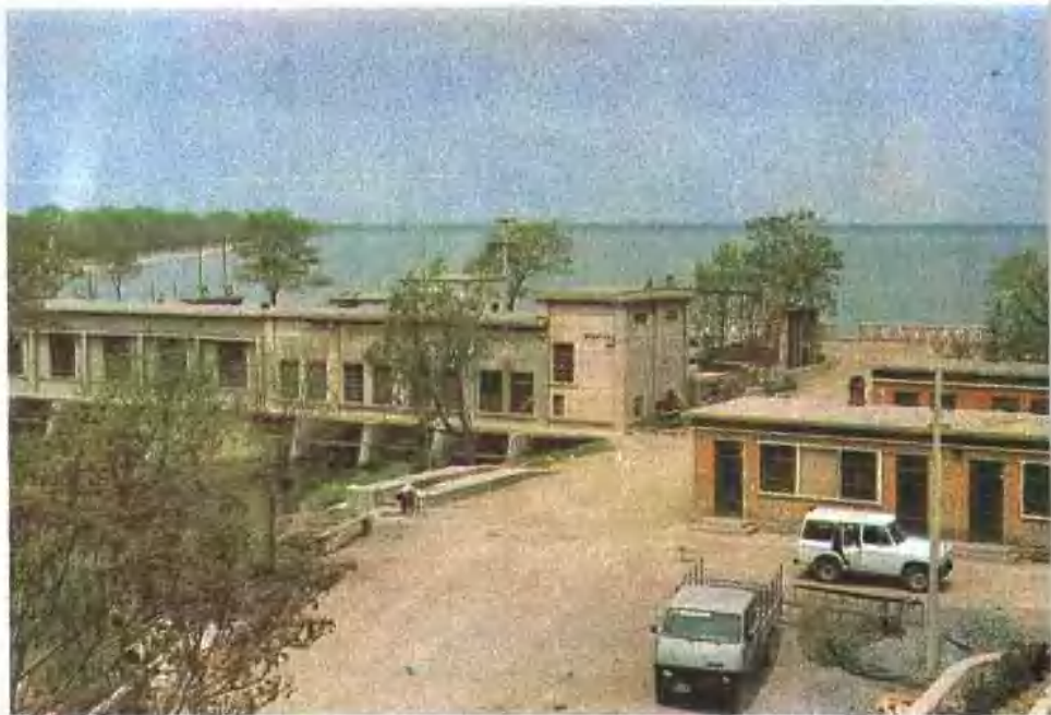
黄港第一水库泵站
