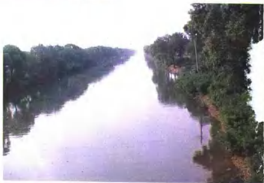
中心桥泵站引河
