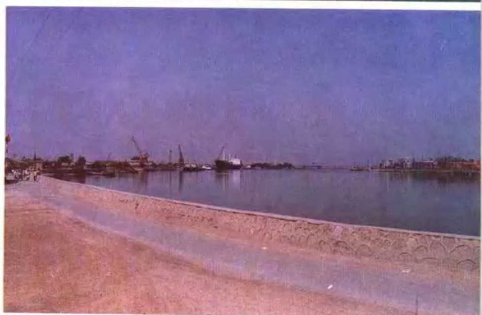
海河堤防塘沽城区段浆砌石护堤
