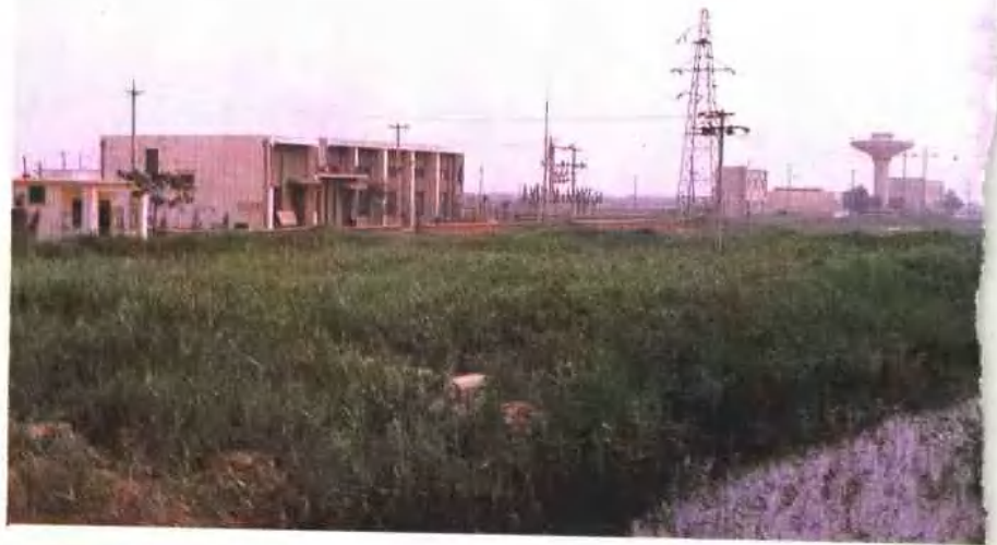
引滦入塘输水工程 杨北公路泵站
