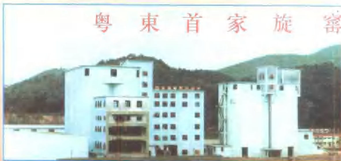
引进日本小野田公司 RSP 窑外分解干法回转窑水泥生产
