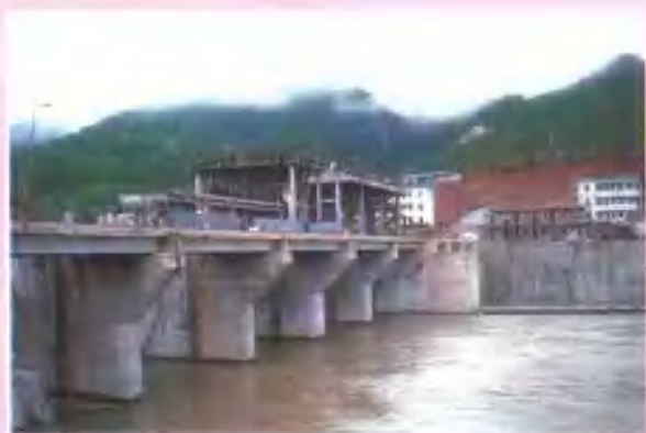
建设中的梅县瓜洲水电站
