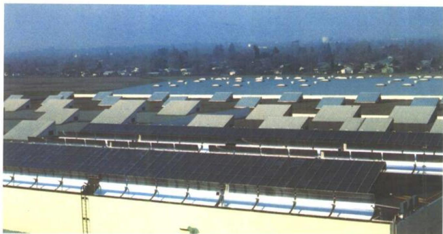
彩图17 平板型和聚焦型热水器的组合提供工业用热水
