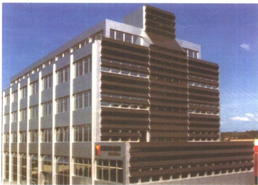
彩图18 既供电又供热的光伏装置
