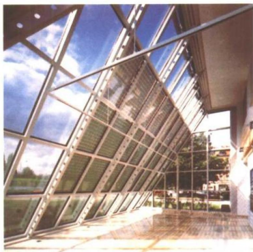
彩图10 倾斜安装 (倾角为 30^{\circ} \sim 45^{\circ} ) 的光伏阵列具有最高的效率
